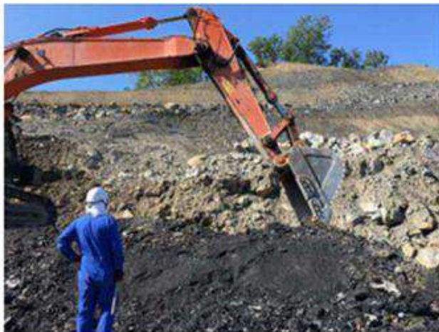
写真 2-1 重機による切削作業
