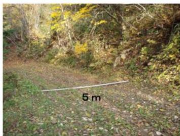
③林道全幅が5mのため、ボーリング掘削時は通行止めが必要
