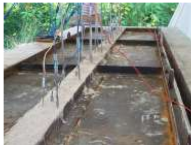
熱電対の埋設状況
