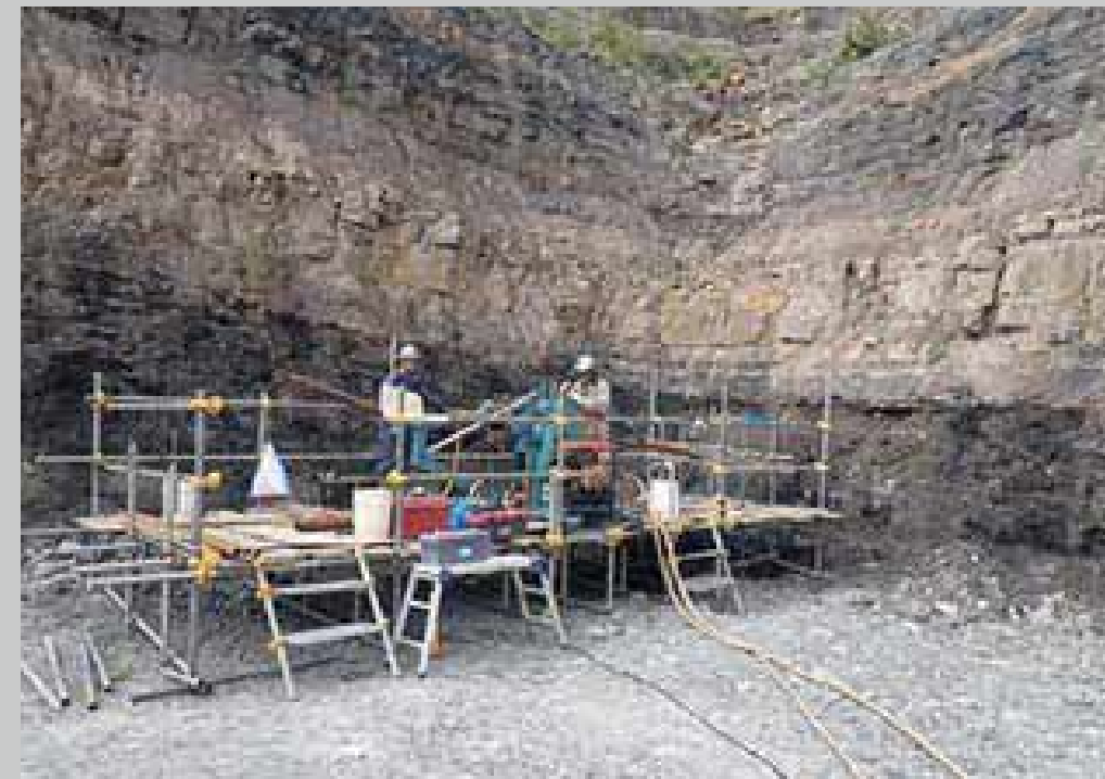
石炭層を20m掘削
