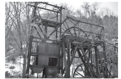
1 旧北炭幾春別炭鉱錦立坑 にしきたてこう やぐら
