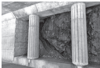
5 ひとまたぎ覆道 ふくどう これが断層！大地が動いた証しを間近で見ることができます。
